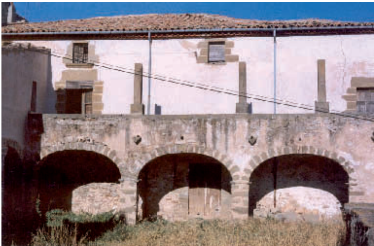
Cal Tella pel darrere de la casa, l'eixida de pedra que dona cobert al pati on es troba l'espai pels carruatges
